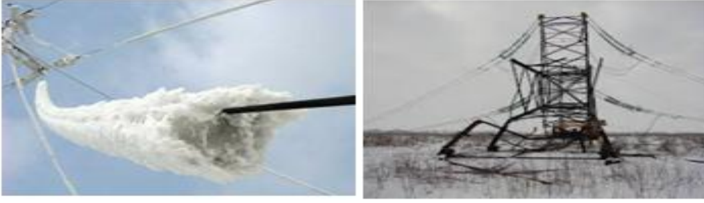
Şəkil.EVX lərdə yaranan buzlaşma və onun nəticəsində dayağın qırılması
