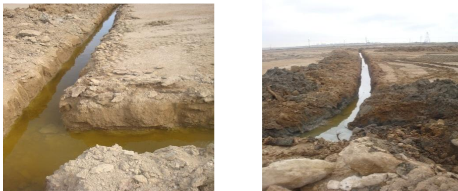
Şəkil 1. Drenlərin qazılması və drenlərdə suyun səviyyəsi
